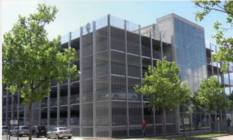
Parking garage Dynamostraße, Mannheim
