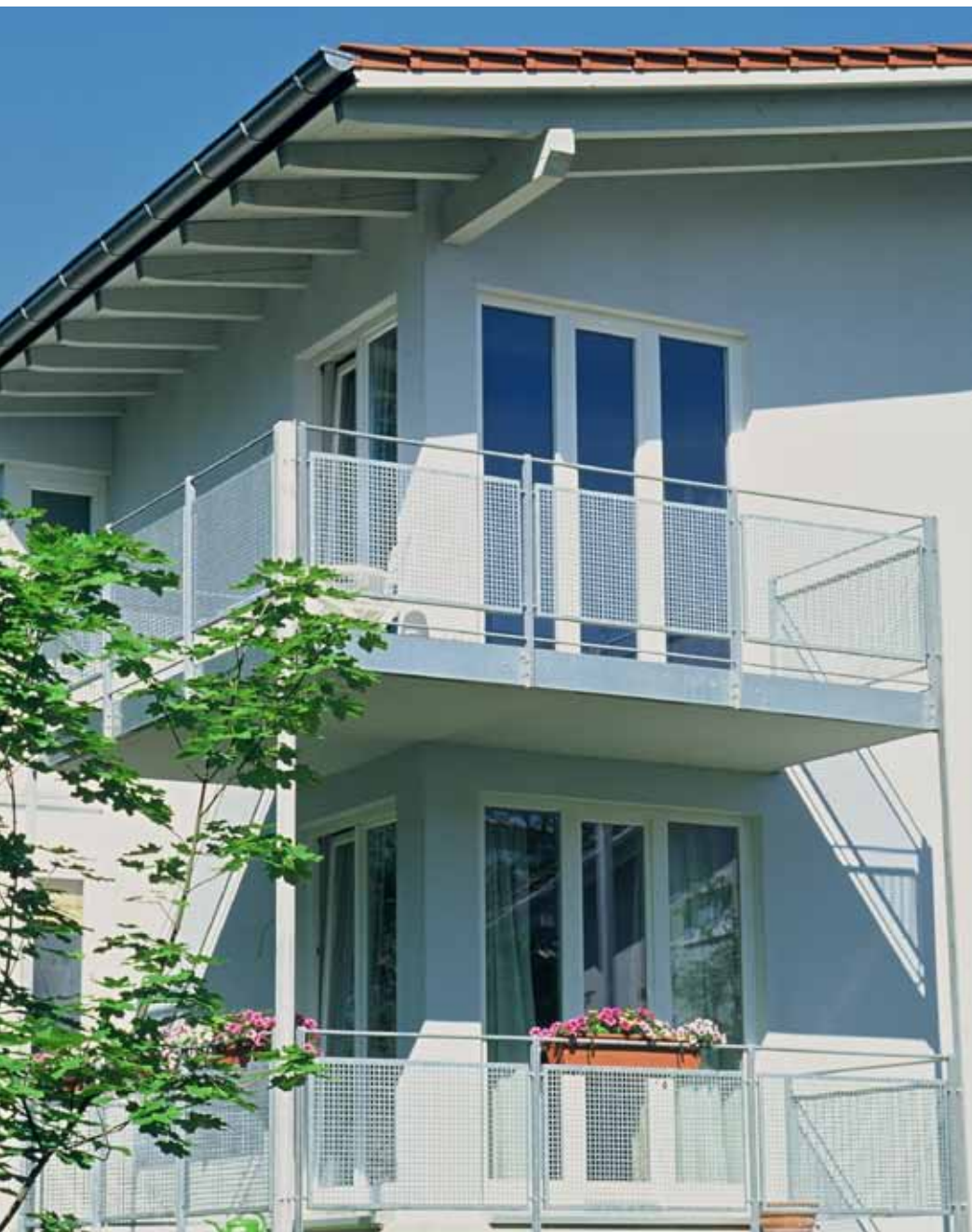
Wohnanlage Ottobrunn, Munich
