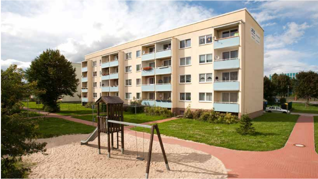
Hallesche Strasse, Eisleben
